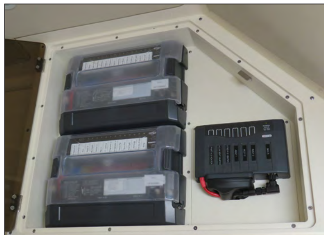
CZone Control Output Modules
